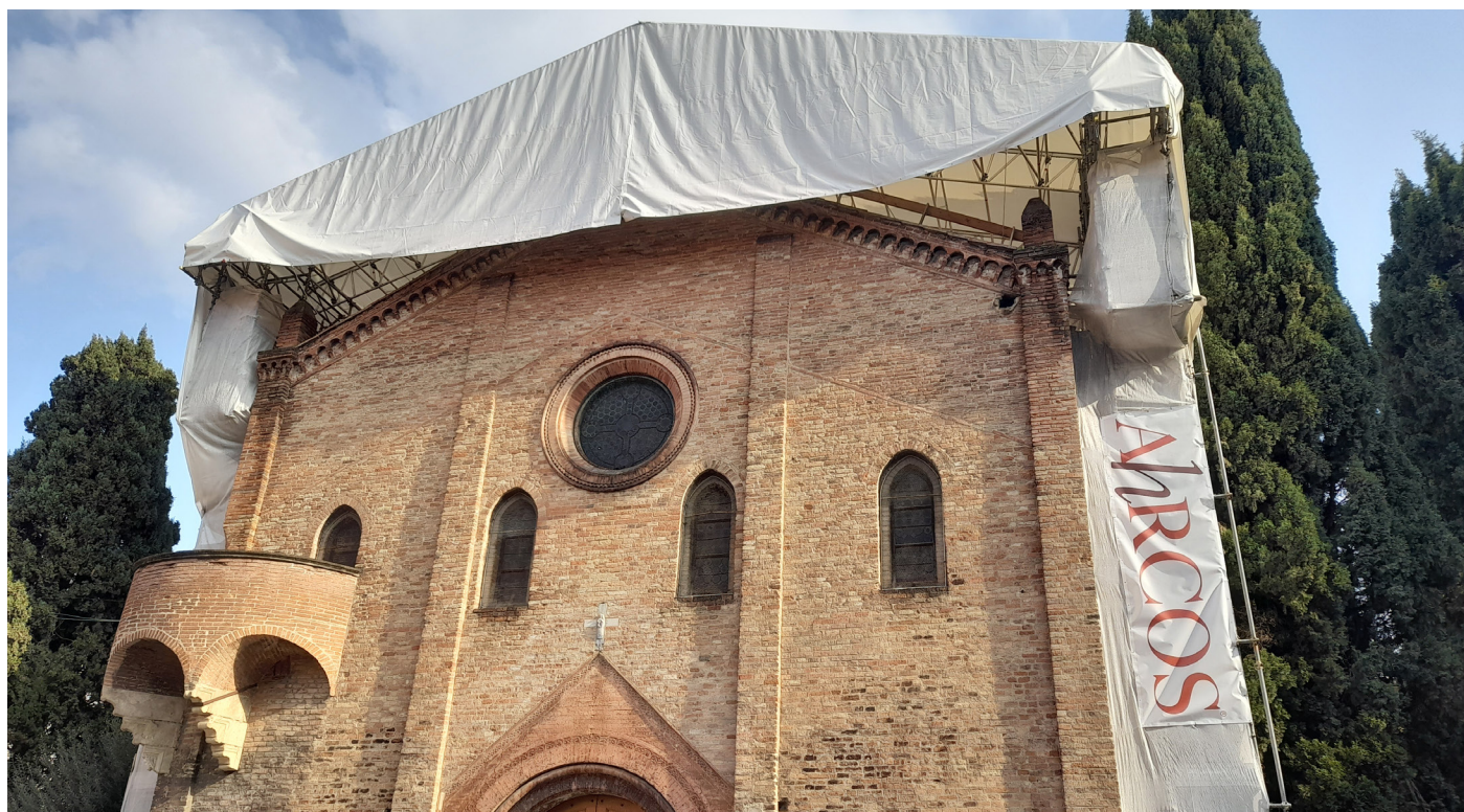
I lavori di ristrutturazione del Complesso delle Sette Chiese
