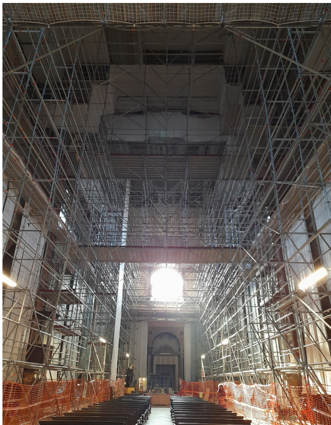
La struttura per il restauro all'interno di San Giacomo
